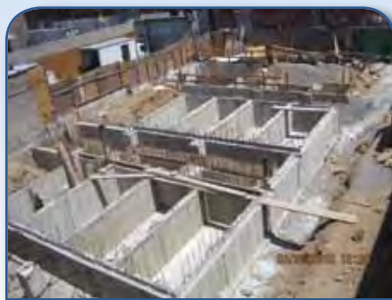
ביים גיסן די צעמענטענס פאדלאגע און צעמענטענע ווענט וועלכע דינען אלס שוין פאר די בורות הטבילה עס זאל נישט כאפן קיין שפאלטענס
