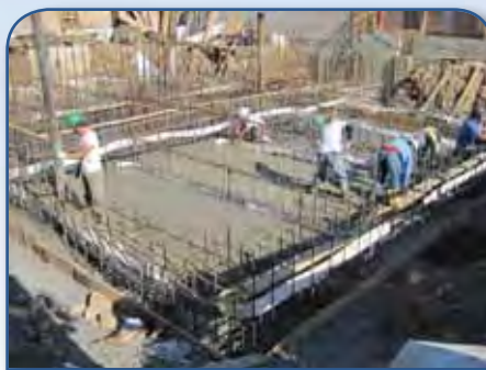
ביים גיסן די צעמענטענס פאדלאגע און צעמענטענע ווענט וועלכע דינען אלס שוין פאר די בורות הטבילה עס זאל נישט כאפן קיין שפאלטענס
