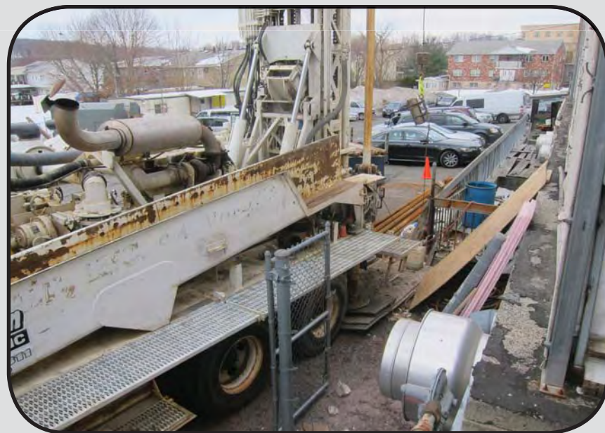
מעכטיגע גרוב-אפאראטן אראפגעברענגט איבערצוארבייטן דעם וואסער-קוואל נעבן ביהמ"ד הגדול ארויסצוהעלפן דעם וואסער סופליי פאר קרית יואל
